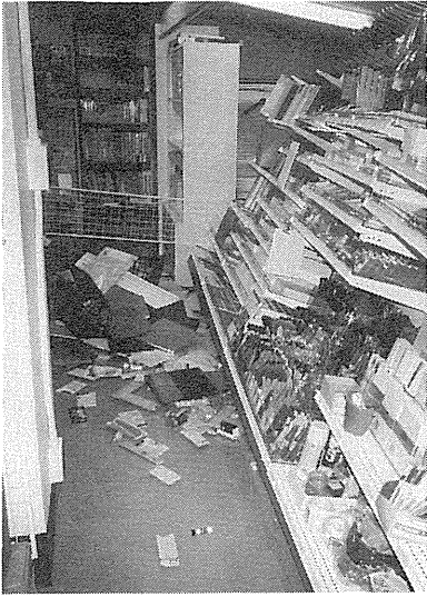
棚が後方へ倒れ、商品が落下した 生協店舗内（8号館2階）
